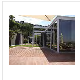
CSH #23-C (Triad), (Vivienda C de un grupo de tres viviendas) de Killingsworth, Brady, Smith & Assoc., Los Angeles (1960-1961)
