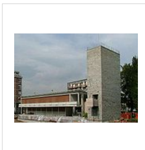
Casa del Fascio en Lissone (1938-1939)
