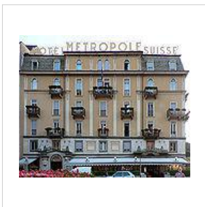
Hotel Metropole Suisse. Reestructuración de la fachada, Como (1926-1927)
