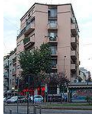
Edificio de viviendas Lavezzari, Milán (1934), con Pietro Lingeri
