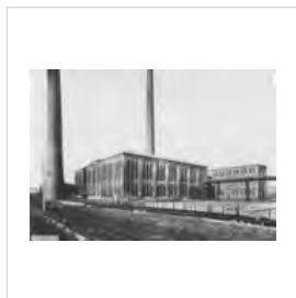
Sala de calderas, Kopalnia Anna (1914)
