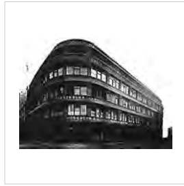
Edificio de oficinas en Breslavia (1909)
