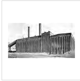
Central eléctrica en Schulau (1927-1929) con Werner Issel
