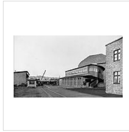
Garaje Gollnow & Sons, Stetin (1928)
