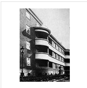
Viviendas en el Parkring, Insterburg (Alemania) (1923-1924)
