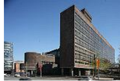
Edificio Tsentrosoyuz (junto con Nikolai Kolli), Moscú (1928-1936)
