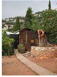
Cabaña en Roquebrune-Cap-Martin (1949)
