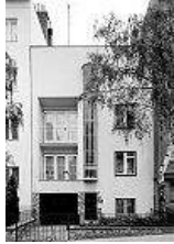
(1931) | Edificio de 2 apartamentos en Zdráhalova 34 de Zikmund Kerekes
