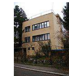
20: Casa Bautz de František Kerhart
