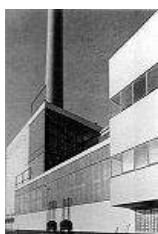
(1929-1932) | Central eléctrica ESSO de Jaroslav Fragner
